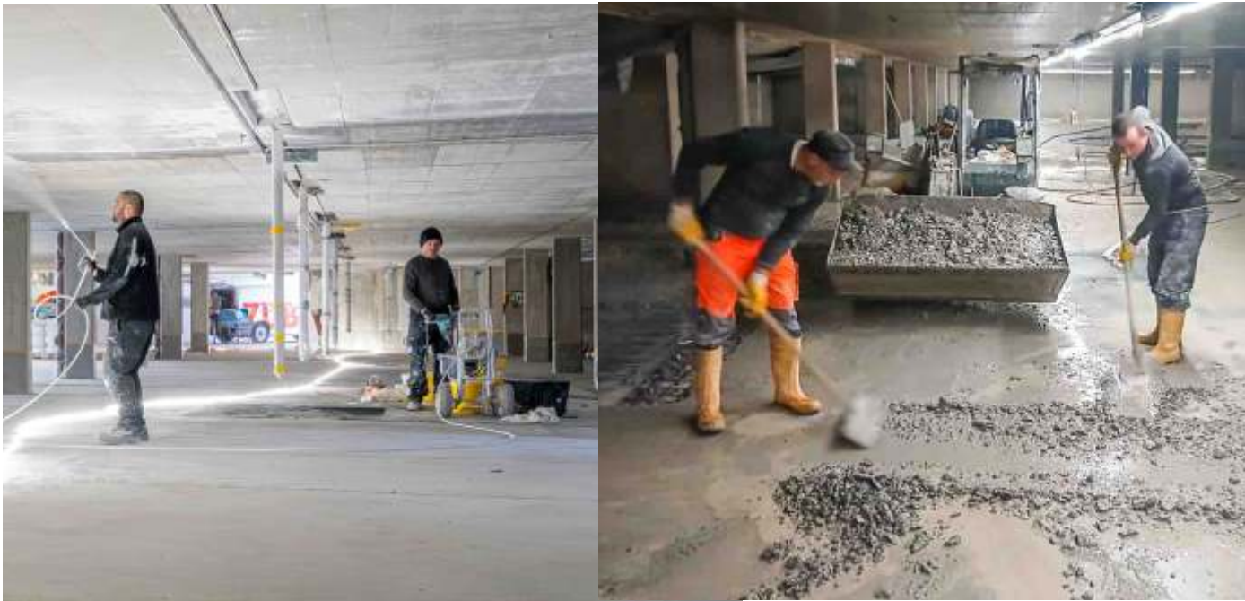
Sanierung der Tiefgarage
