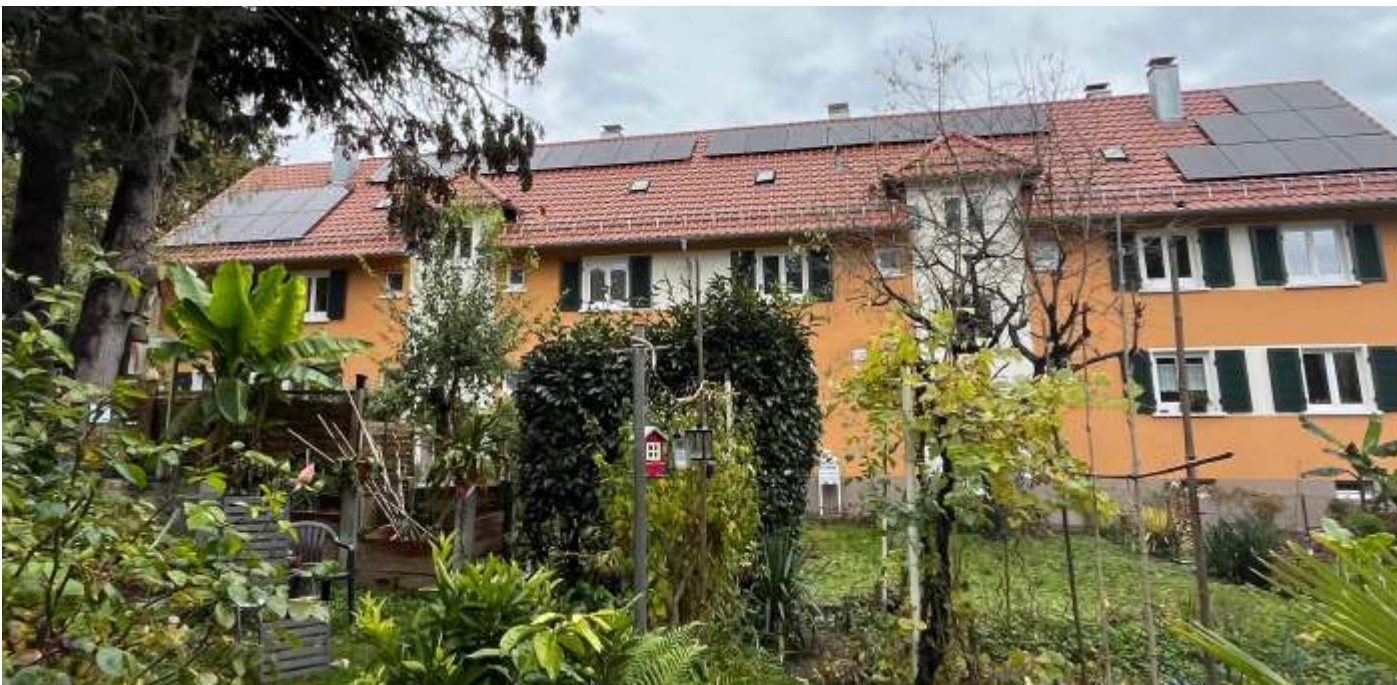
Photovoltaik in der Austrasse 71/73
