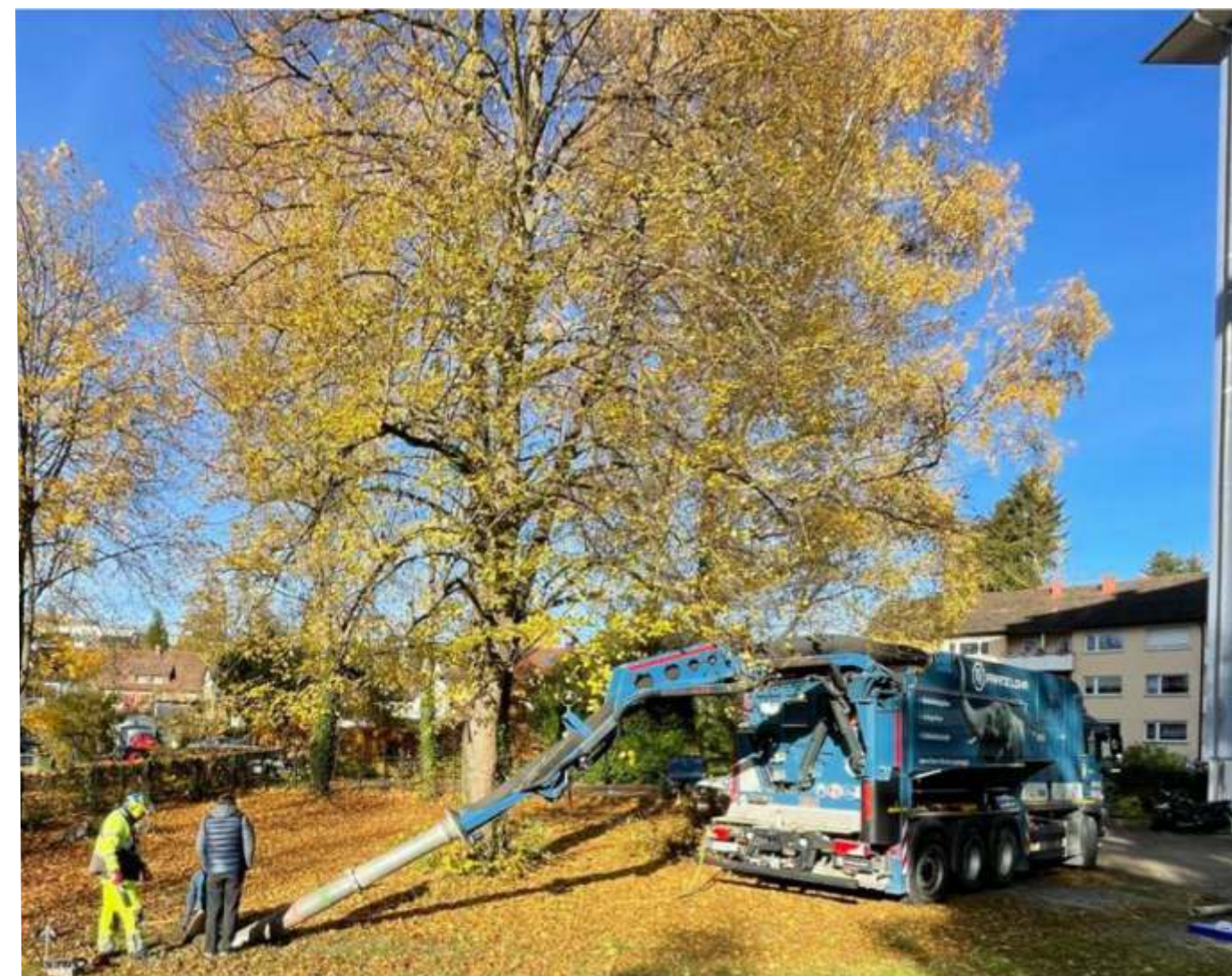
Die Wurzeln der etwa 80 Jahre alten Winter-Linde wurden im Dezember 2025 mit einem Saugbagger nach Vorgaben von Baumpfleger*innen sorgfältig freigelegt, um den Baum zu erhalten.
