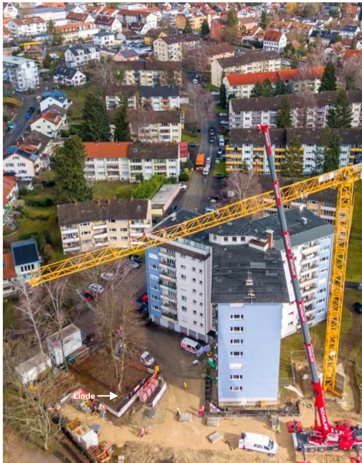
Einrichtung der Baustelle Peter-Rosegger-Weg. Der Kran mit einer Hakenhöhe von 43 m und einer Ausladung von 50 m war nötig, um die Linde nicht zu beschädigen.
