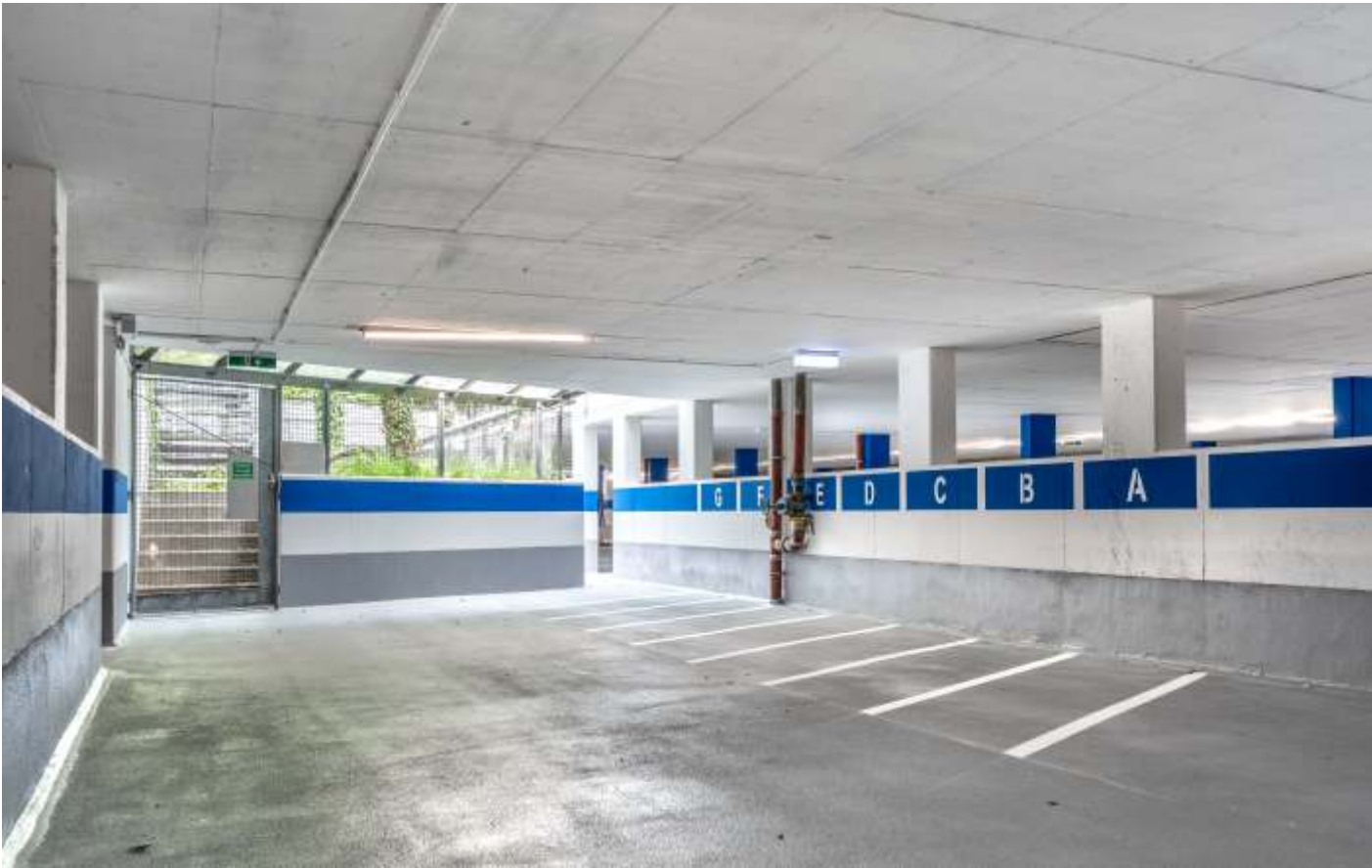
Tiefgarage nach der Sanierung
